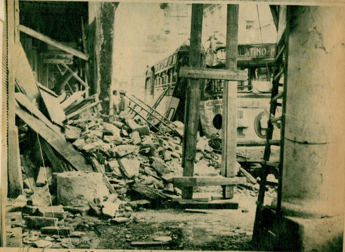
Rub. Accidente del tránsito... Dos heridos junio 18/967 Columnas y paredes derribadas, un vehículo de transporte público seriamente dañado y dos personas heridas. Es el resultado del espectacular accidente del tránsito ocurrido ayer en la esquina de Monte e Indio. Un ómnibus de la ruta 16 chocó violentamente con una columna del viejo edificio que allí existe causando un derrumbe parcial. Otros dos vehículos estuvieron también envueltos en el accidente. (Fotos Rubén González).
