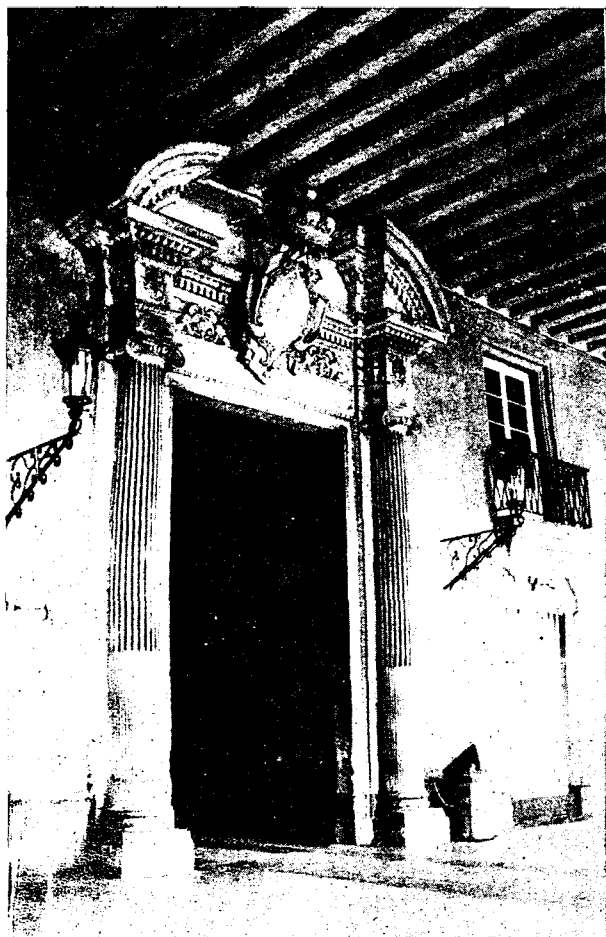
Puerta principal que da hacia la Plaza de Armas del antiguo Palacio de los Capitanes Generales, hoy hermosamente restaurado y respetado su escudo de Armas, y sede del Ayuntamiento de la Habana
