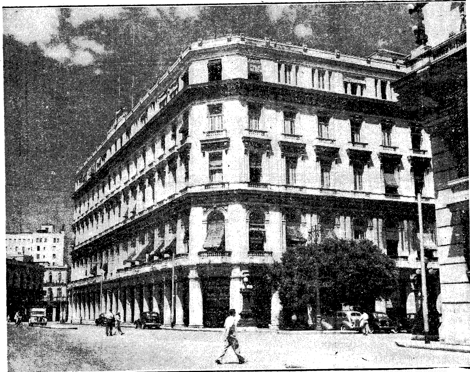
LA MANZANA DE GÓMEZ. — Donde conocimos hace medio siglo las Ruinas de Zulueta, hoy se levanta este edificio de tiendas y oficinas, fundado por don Andrés Gómez y Mena en la manzana que circundan Zulueta, O'Reilly, Neptuno y Monserrate. (Foto Euendia).
