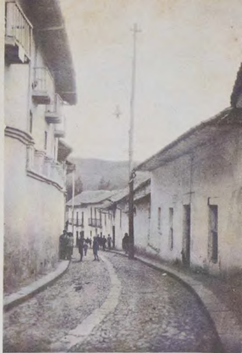
Del Quito colonial: la calle de la Ronda.
