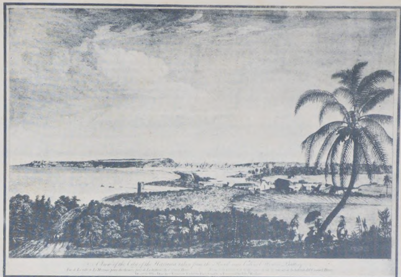
VISTA DE LA CIUDAD DE LA HABANA DESDE EL CAMINO DE LA BATERIA DEL CORONEL HOWE
